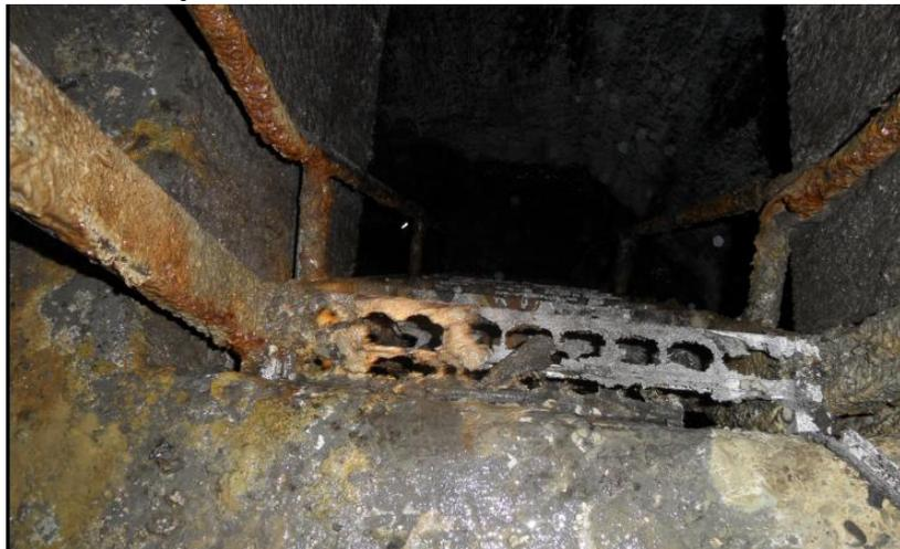
Разрушение элементов лестниц при воздействии биогенной сернокислотной коррозии в шахтах
