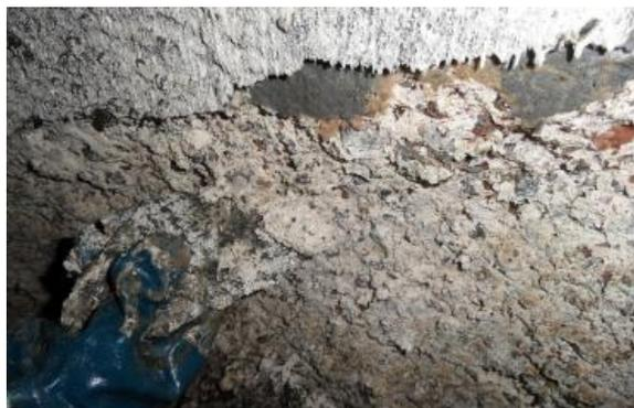
Разрушение защитного покрытия Конусит КК10 в шахте в условиях воздействия биогенной сернокислотной коррозии
