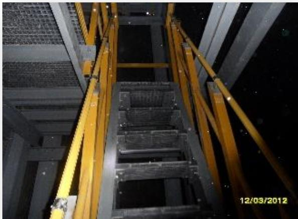
Технологическое оснащение шахт (устройство ограждений, лестниц, площадок) при строительстве Главного канализационного коллектора (2013г.)
