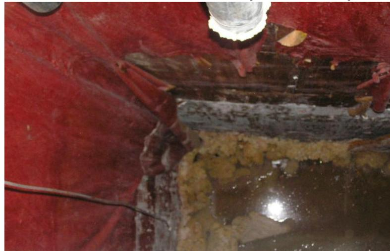
Разрушение полимерного покрытия в баках для хранения сернокислого алюминия (рН=1-2)
